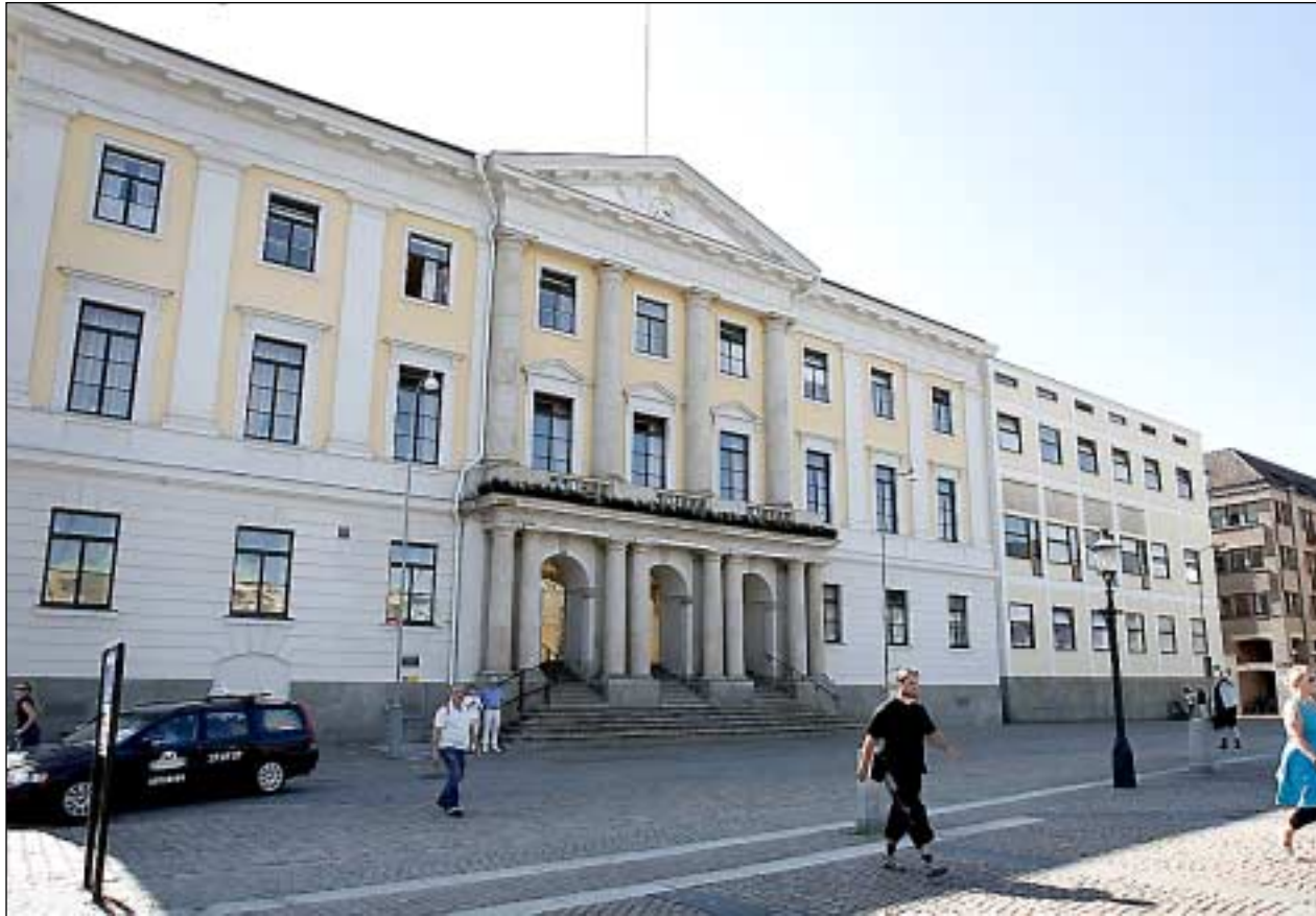
MAKTENS FLOTTA FASADER. Göteborgs rådhus är egentligen två. Den äldre delen stod klar 1672, men är påbyggd 1817. Tillbygget till höger gjordes 1937. Hit vill kommunalråden och delar av stadsförvaltningen gärna flytta.
